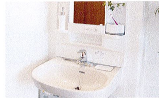
車いす対応洗面台(ベストライフ京都桃山)
