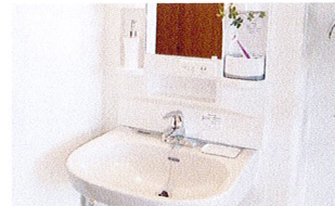
車いす対応洗面台
