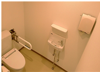
最新の設備を備えた福祉対応WCも配備しています。
