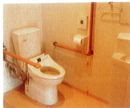
居室内トイレ
