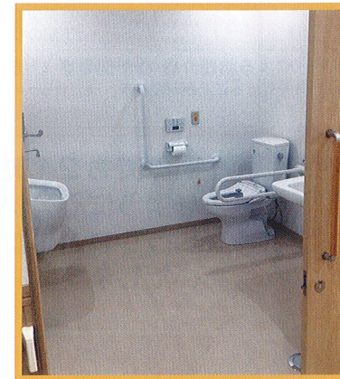
介助用トイレも設置しております。
