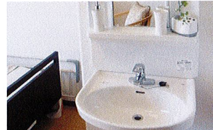
車いす対応洗面台
