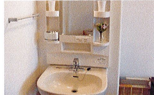
車いす対応洗面台
