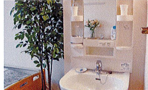
車いす対応洗面台
