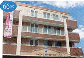
4号館 堺市堺区今池町 66室
